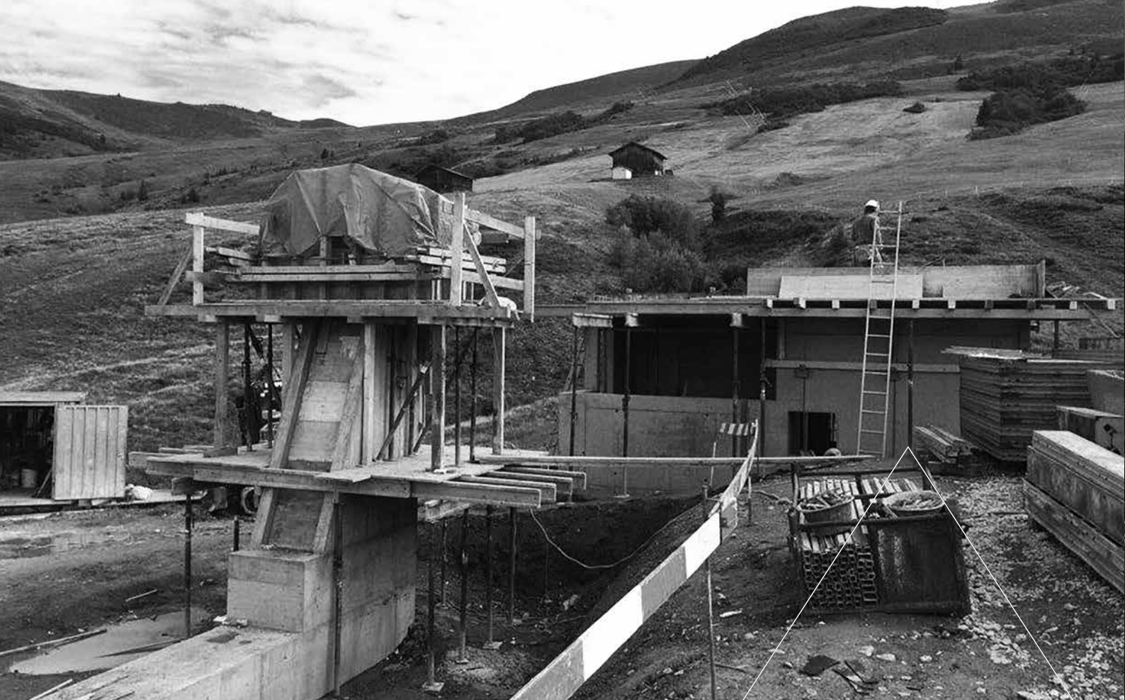
Eine Station wächst aus dem Boden
